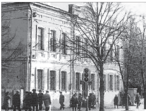
Будинок по вул. Сумській, 34
